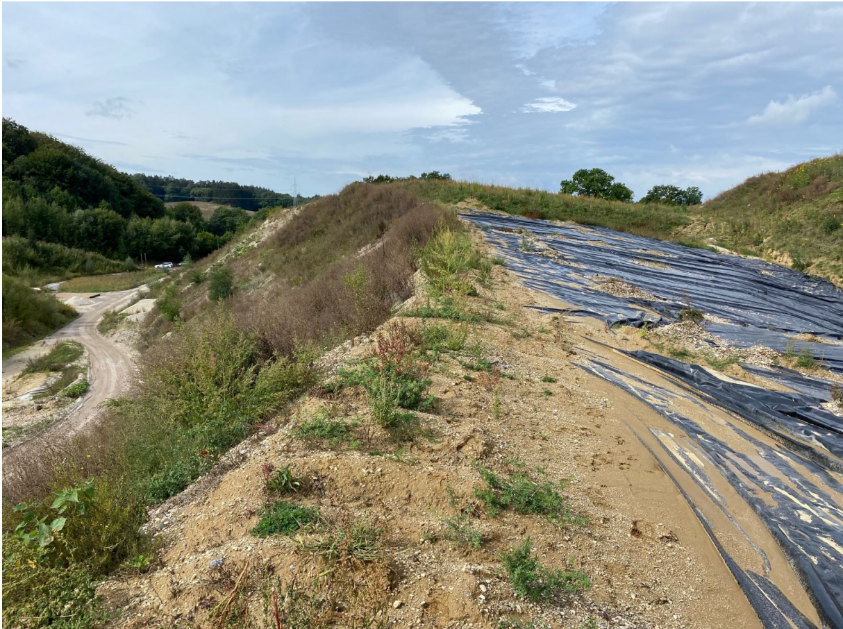
Blick auf die Böschung zwischen der Deponiezufahrt und dem bereits verfüllten Deponiebereich, auf dem eine Photovoltaikanlage errichtet werden soll. Mit dem Anlagenzaun ist ein Abstand von 5 m zur Böschungskante einzuhalten, um diesen Standort zu erhalten.
