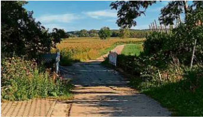
Die zu sanierende Ilmbrücke
