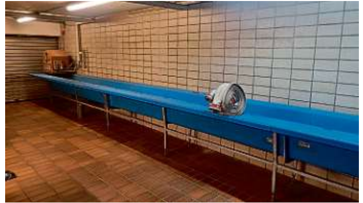
Die alte Schlauchwaschanlage hat ausgedient.
