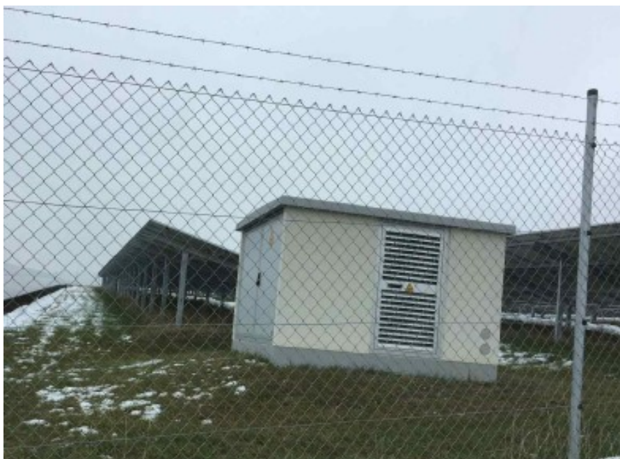
Die Trafostation einer gleichartigen Photovoltaik-Freiflächenanlage. Der Trafo ist deutlich niedriger und schmaler als die Modultische. Die Wechselrichter und Schalt-schränke werden nicht sichtbar unter den Modultischen montiert. Aufgrund des Brand-schutzes werden Trafos nicht mit Holz verkleidet. Die Fassaden sind unscheinbar gestrichen und bestehen Großteils aus techni-
